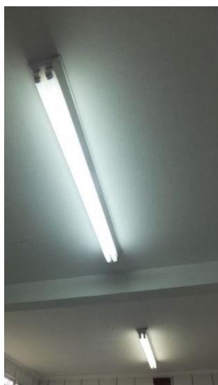
Figura 9. Foto de lâmpadas fluorescentes tubulares encontradas no edifício. As lâmpadas LED indicadas para substituí-las são mais eficientes.
